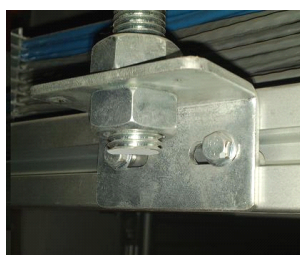
图 2 支撑架角铁与走线架连接
